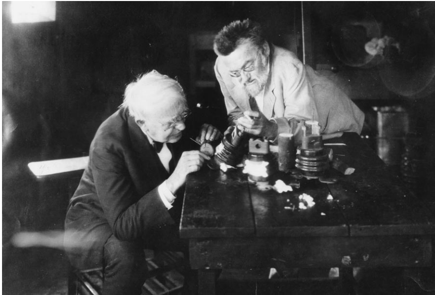
¿Cómo se dan los saltos en la productividad de la mano de obra? No en el lugar de producción, sino mediante descubrimientos creativos que cambian el ambiente en el que se realiza el trabajo. Tomás Alva Edison (izq.) trabaja con el ingeniero Charles Steinmetz en 1922.
